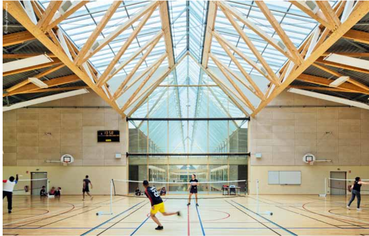
Une structure bien charpentée Des poutres treillis d'une portée de 24 mètres dominent les deux gymnases à l'extrémité est du bâtiment. On devine en arrière-plan la rue intérieure avec les salles de classe de chaque côté.
